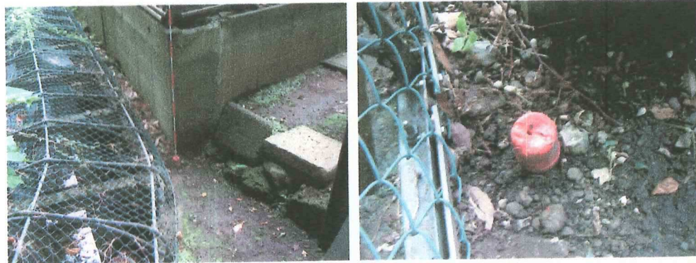
境界点番号 1 既設プラスチック杭
