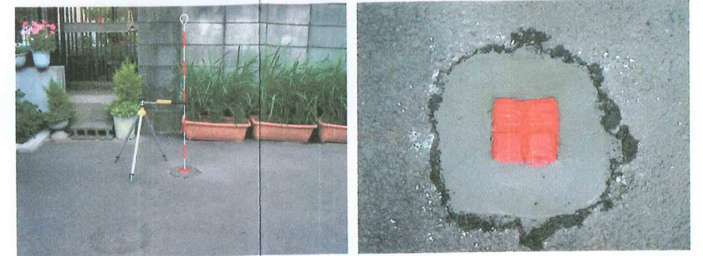
境界点番号 4 新設民間境界石標 国土調査成果により復元 平成16年7月15日埋設
