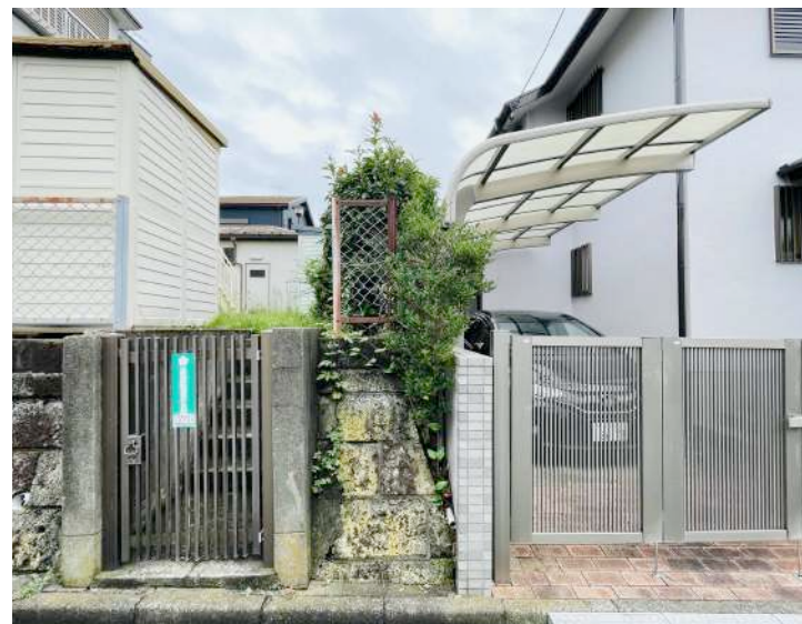
⑥ 南西側 隣地境界部分擁壁の状況
