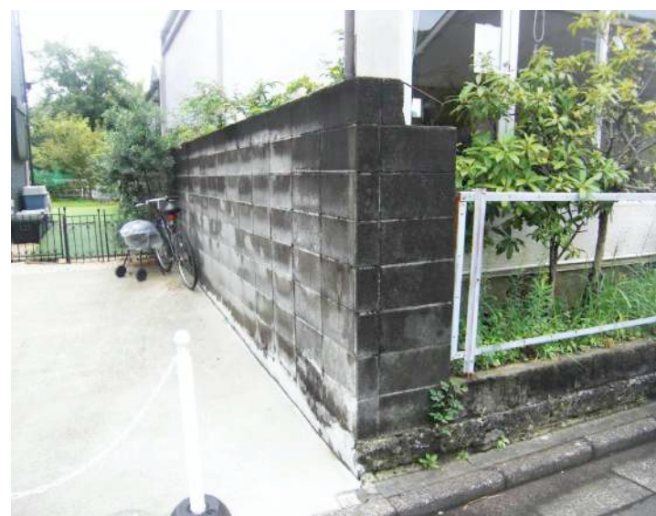
③ 北東側 隣地境界部分CB塀の状況
