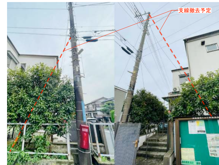
⑧ 北西側 既設電柱の状況
