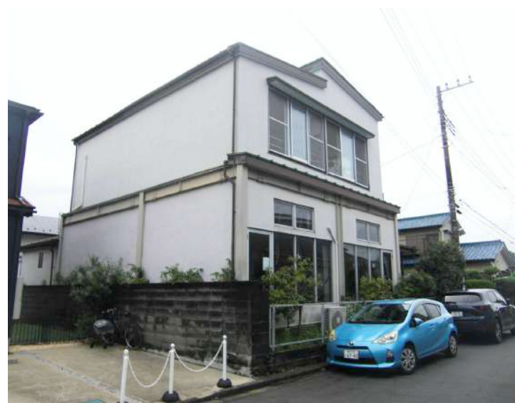
② 北東側 既存建物全景
