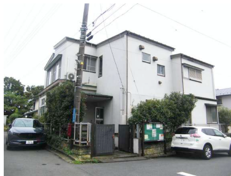
① 北西側 既存建物全景
