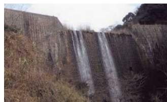
五助堰堤（兵庫県）
