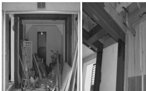
(図-4) 鉄骨フレーム (等価壁倍率に換算)
