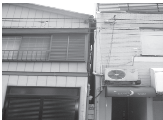
木造家屋の沈下修復
