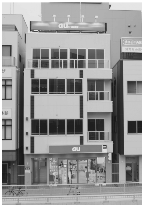
ペデストリアンデッキ上の外観
