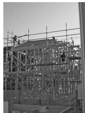
上棟した全景
