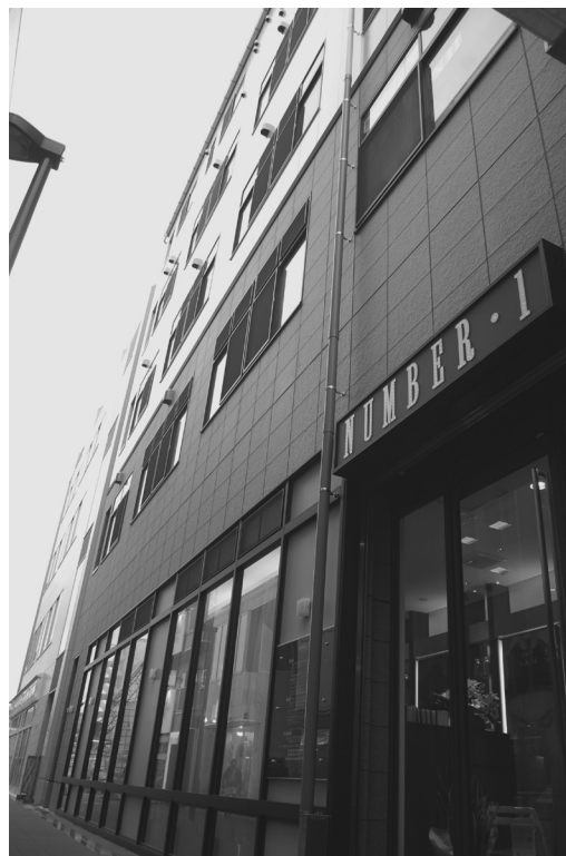
北側6m通路からの見上げ
