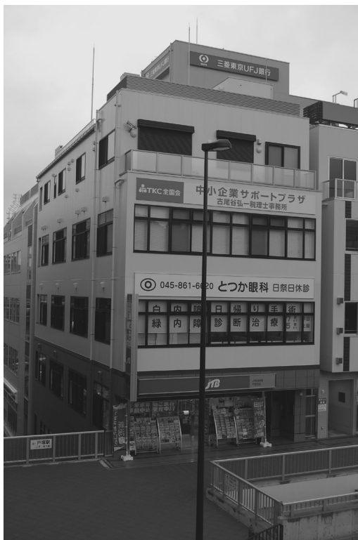
トツカーナを出て3階デッキから見た外観
