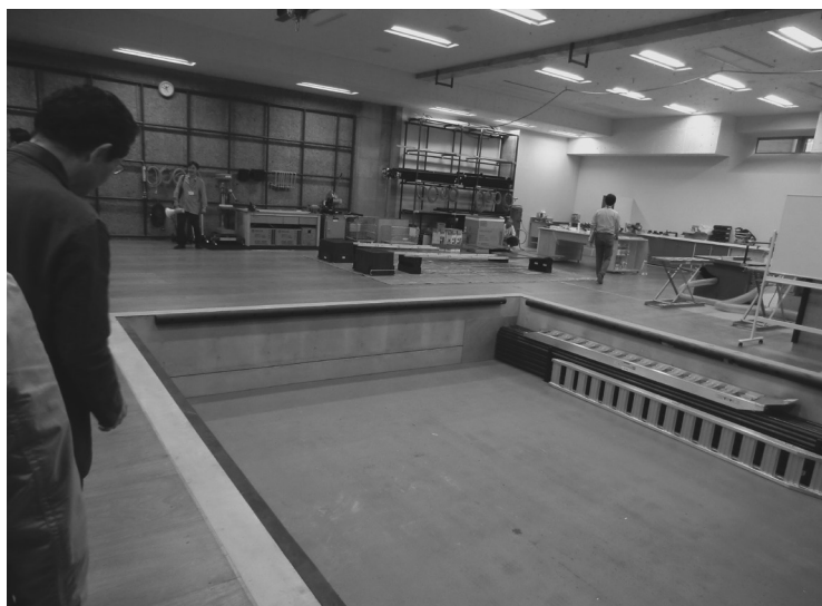
1階大道具搬入ヤード
