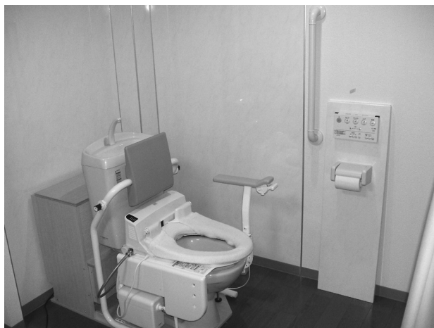
トイレ内部写真
