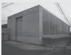
外部（RC部分）
