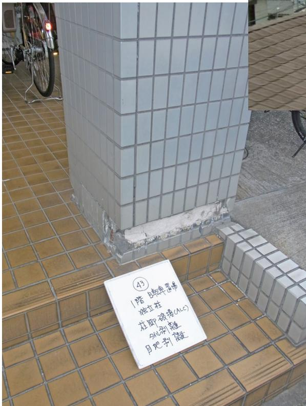
▲ 鉄骨3F建の柱脚 破損 (今川地区)
