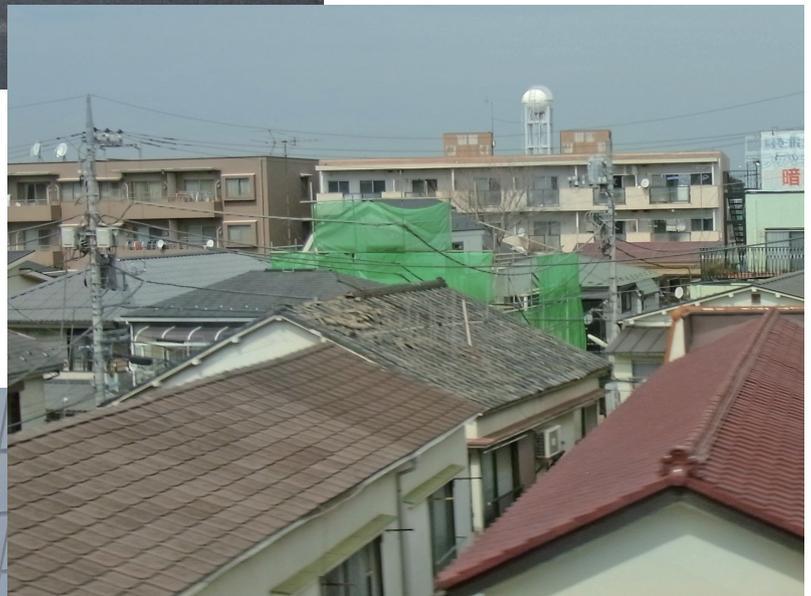
▲ 屋根の瓦破損とアンテナの倒壊 (阿佐ヶ谷地区)
