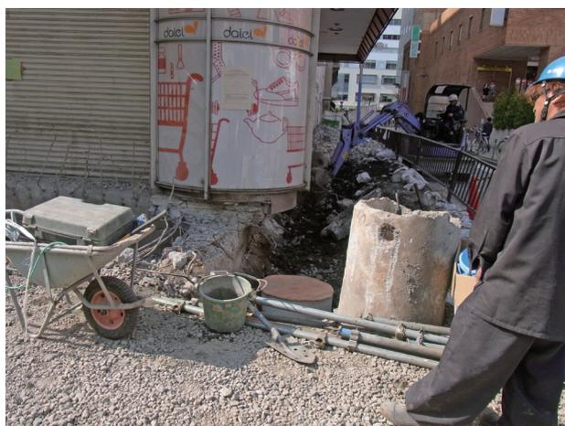
▲ マンホールの突き上げと境界の破損 (横浜駅西口ダイエー前)
