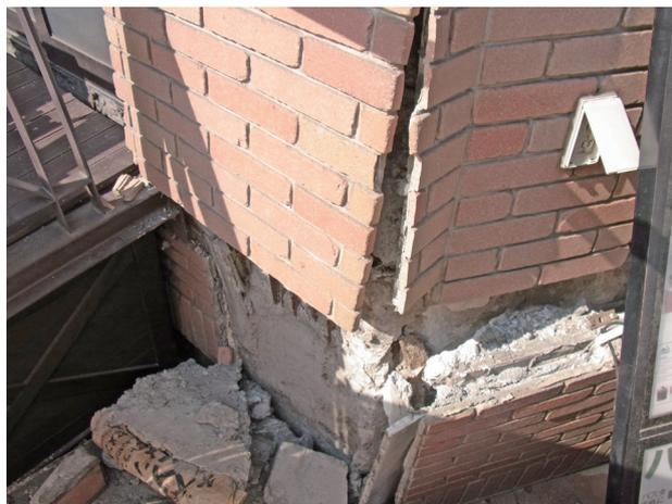
▲ 柱脚の破損と仕上げタイルの剥離 (横浜駅西口)
