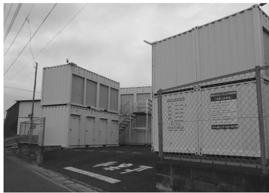
⑨コンテナレンタルボックス
