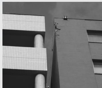
写真2 隣棟ビルと衝突
