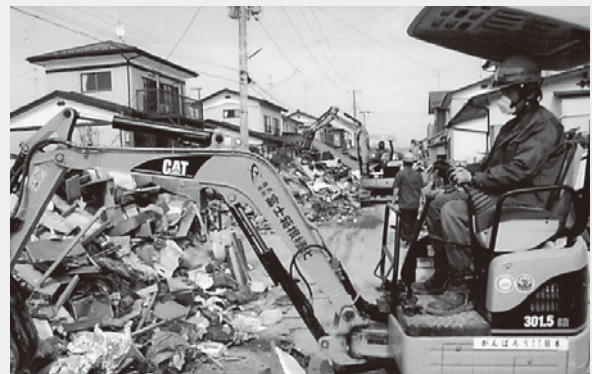
自社重機にて瓦礫の処理
