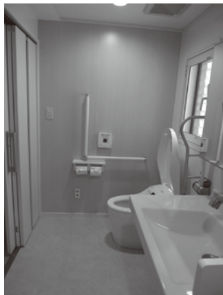
トイレと洗面所を車椅子使用に改修した事例
