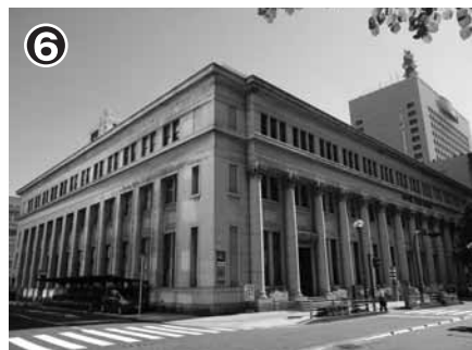
⑥ 日本郵船 / 昭和11年に和田順顕建築事務所の設計により、日本郵船横浜支店として建てられた。施工は大林組。近代化産業遺産認定。
