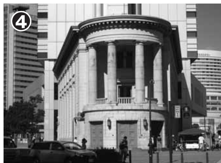
④ 横浜アイランドタワー低層部 (旧第一銀行横浜支店) / 1929年(昭和4年)に建設されたこの建物は、関東大震災復興期における典型的な銀行建築である。設計者は西村好時氏と清水組設計部。
