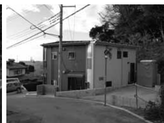
敷地高低差を利用して 階段踊り場から駐車場へ
