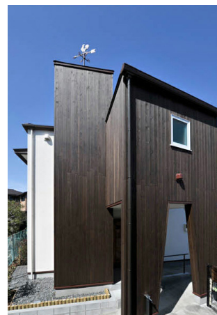
・外壁も県産杉板
