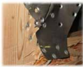
写真③筋かい金物及び土台
