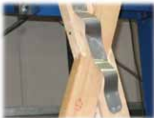
写真③接合部金物
