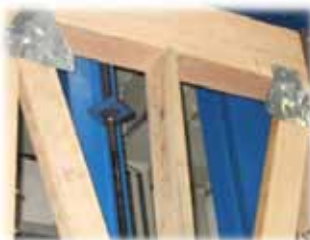
写真③筋かい金物上部
