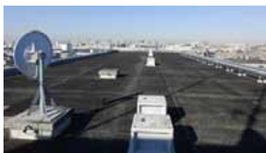
ビル屋上防水調査（アスファルト露出防水）
