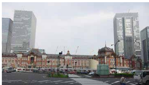
東北の雄勝石が屋根にのった東京駅外観
