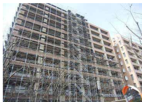
集合住宅外壁メンテのためのビティ足場構築
