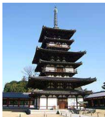
薬師寺東塔（再生工事中）
