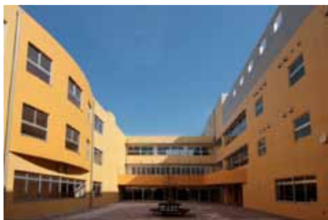
【中庭からの見上げ】
