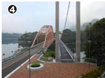
④ 三井大橋・三井そよかぜ橋 三井大橋(みいおおはし)／ 太井の神奈川県道513号鳥屋川尻線の途中に架かるアーチ橋。かながわの橋100選に選ばれている。鋼ランガー橋で、橋長212m、幅員5.5m。 三井そよかぜ橋／ 歩行者・自転車が三井大橋を通行する際の安全や利便性を確保するため三井大橋横に建設した歩道橋。2012年に開通。
