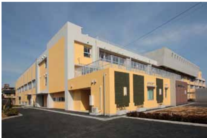
【南西側より全体を見る】
