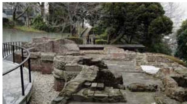
関東大震災で倒壊した80番館跡
