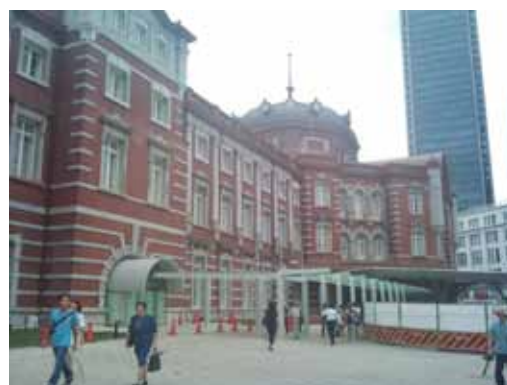
東京駅 ドーム屋根
