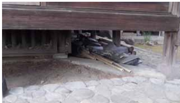
東石の根固め
