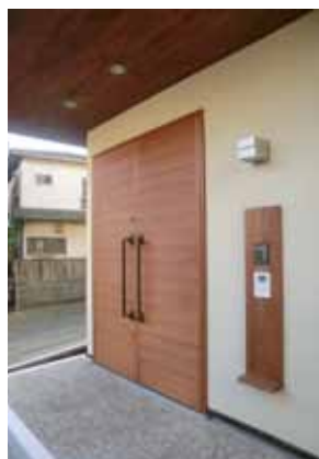
玄関廻り…木製防火玄関扉
