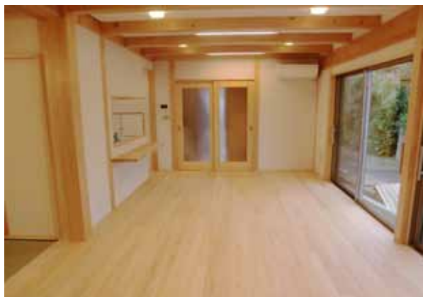
1階みんなのリビング…松の梁表し、床は松縁故板
