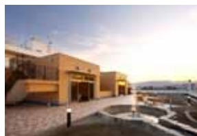
3階屋上：ビオトープガーデン
