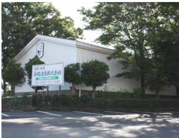
北側から見た仕込み蔵
