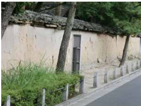
いつか土壁の修復も…
