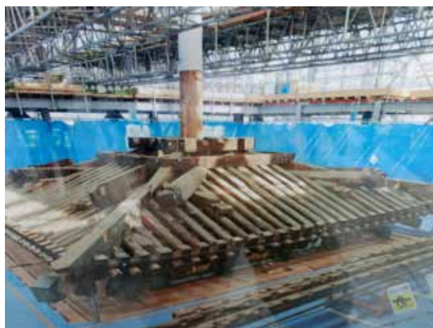
瓦が下された屋根の様子
