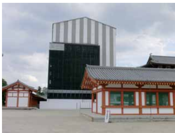
無骨な建屋が外される日が待ち遠しい
