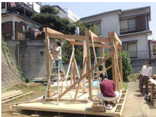
②柱にボルトで挟み梁を固定します。 挟み梁を採用することで部材の重量を抑えています。
