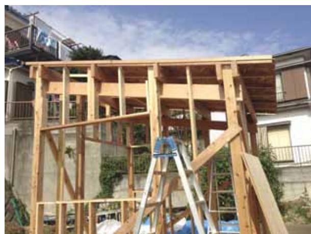
⑥プロトタイプは、この躯体に展示用のパネルを取り付けます。 外部は、樹脂パネルで仕上げて完成となります。
