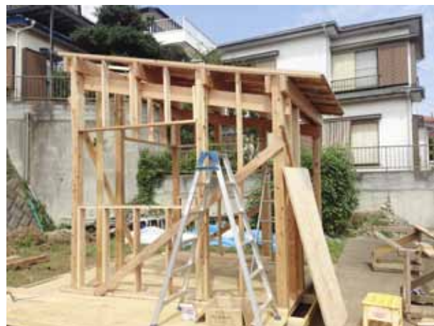
④野地板まで完成しました。 9坪タイプは、このモデルの4倍の大きさになります。
