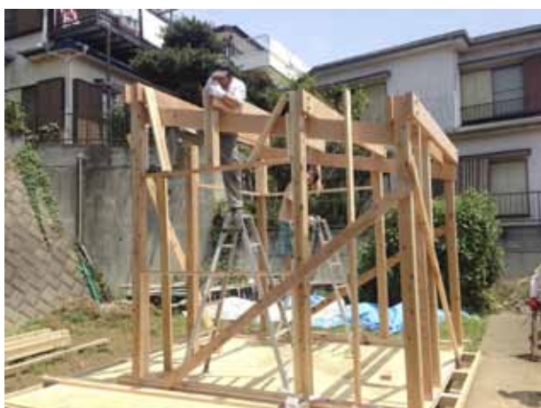
③間柱を支部長が取り付けしています。 作業を行いながらも、いいアイデアがあれば変更を加えています。
