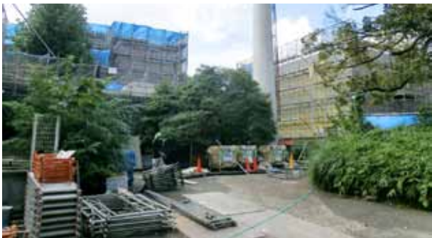
改修工事現場（外観）
