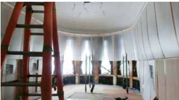
改修工事現場（室内）
