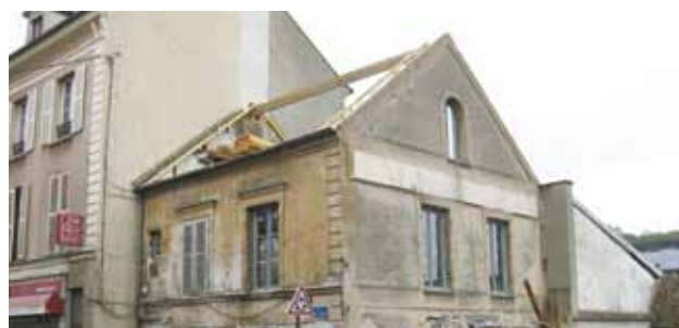
改修工事現場・屋根未工事
