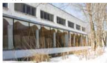
講義室外観 波打つ天井の断面形
