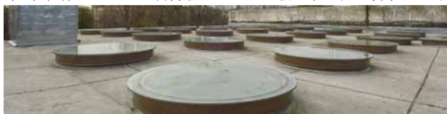
円筒形スカイライトが並ぶ閲覧室の屋上 シンプルなガラスのディテール
