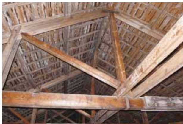
貯蔵庫内小屋組みはキングポストラス
