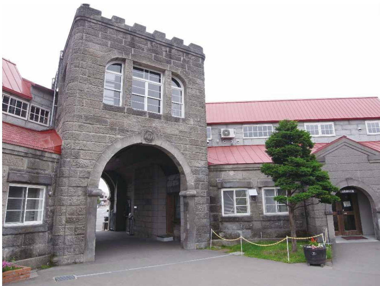
木骨石積造の正門及び事務所棟
