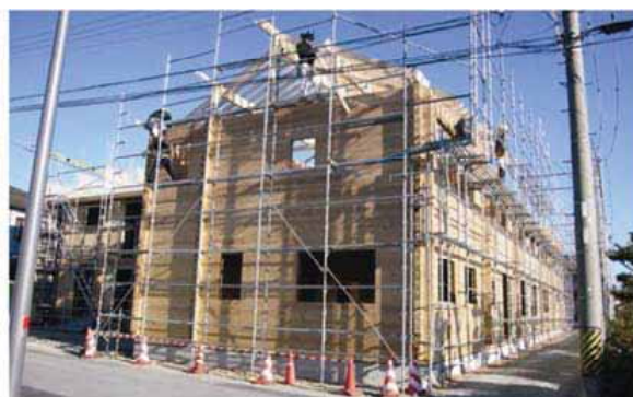
丸太組構法部分の建て方・棟上げ時
