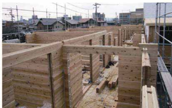
丸太組構法部分の建て方・2階部分施工の様子
