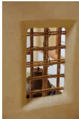
床脇の下地窓は、台目席お点前の手元を照らす (下地窓：はまぐり刃左官仕上)
