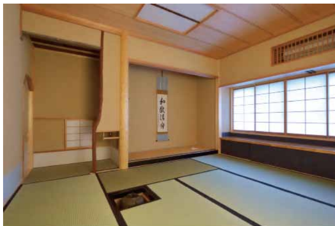
床柱：北山紋丸太、床框：北山面皮黒呂色漆塗、落掛け：吉野杉赤材
