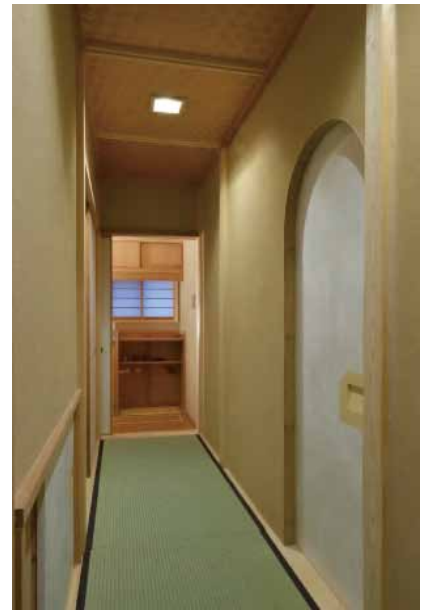
網代天井の畳廊下 突当りに水屋が見える 右手の太鼓機から住まい玄関ホールへ通じる
