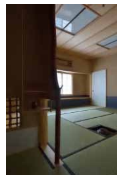
台目席から客座側を見る 袖壁中柱は赤松皮付丸太
