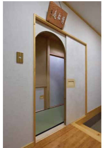
住まいから茶室への出入口に設けられた火盤口 小口はサビ竹が使われている
