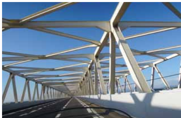
自分の中の東北の入口(利根川に架かる橋)
