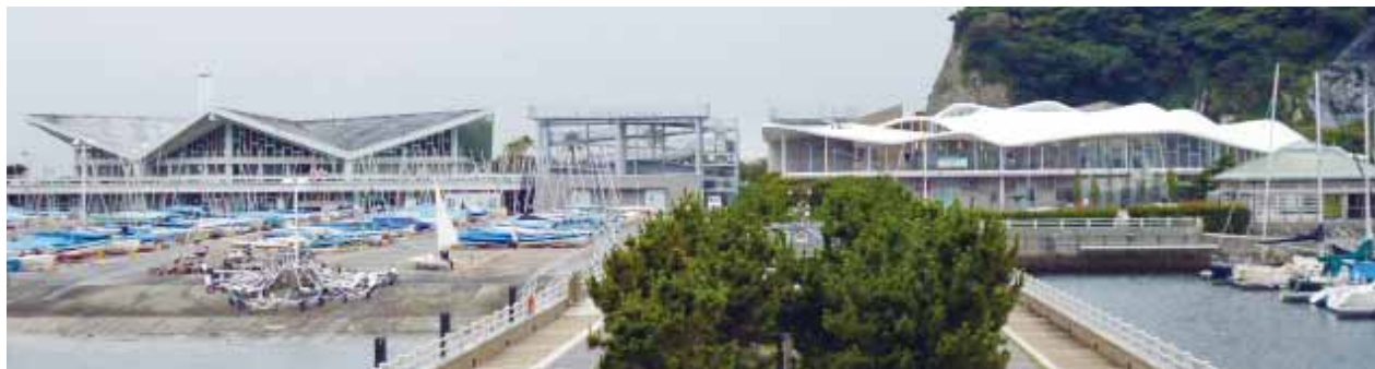
海側からの新旧ヨットハウス。約半年間、新旧ヨットハウスが共存していました。
