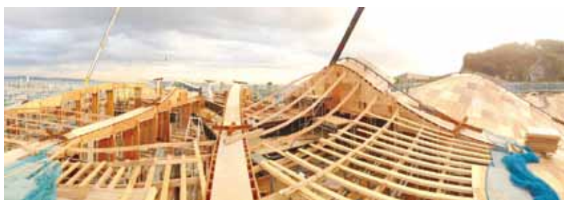
自由曲面屋根の型枠工事状況。まるで恐竜の骨組みのようです。
