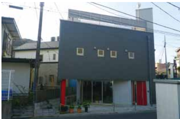
平成26年 横須賀市根岸町-S邸 鉄骨造2階建て
