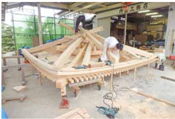
延命寺鐘楼堂 工場での屋根仮組みの様子
