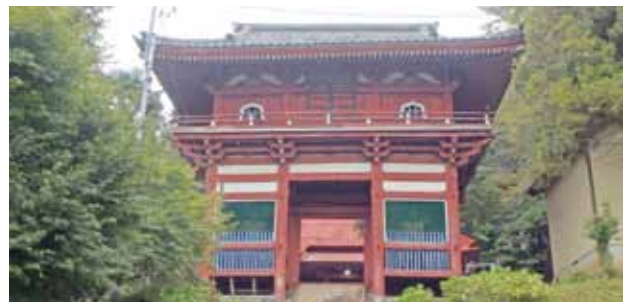
東光寺仁王門 修理前外観
