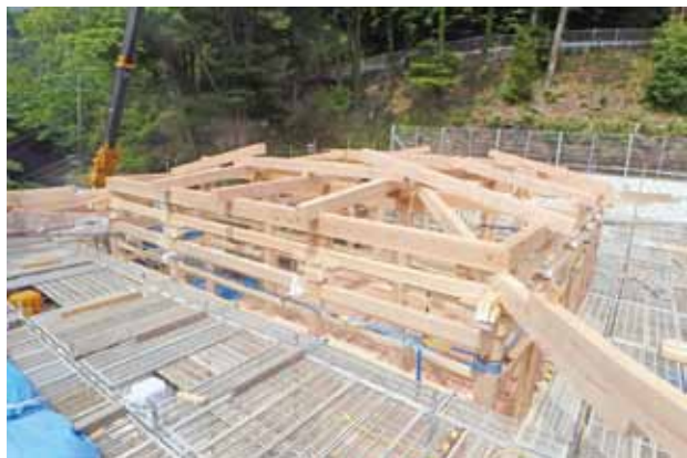
妙誠寺本堂 建方中の様子
