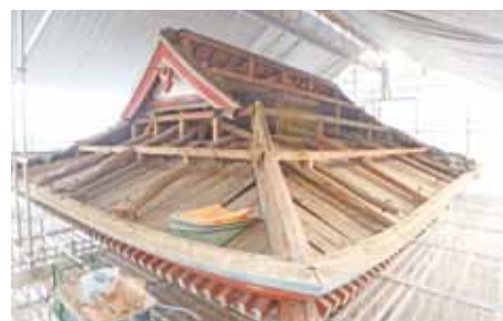
東光寺仁王門 修理解体中の様子
