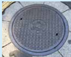
古いタイプのものは幾何学模様が多い：東京帝国大学構内のマンホール
