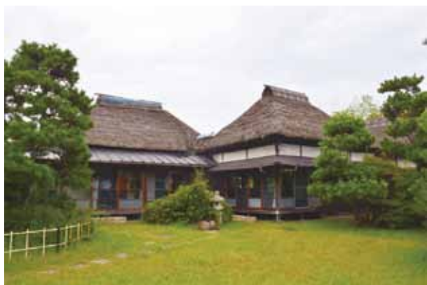
茅葺屋根の公共建築「万代会館」
