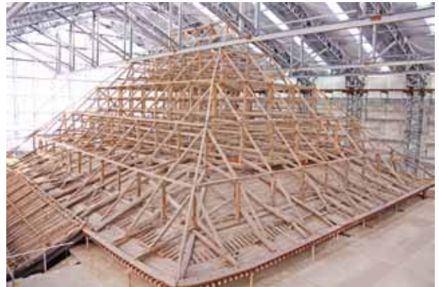
重要文化財宝城坊本堂 修理解体中の様子
