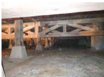
床下フレーム設置状況
