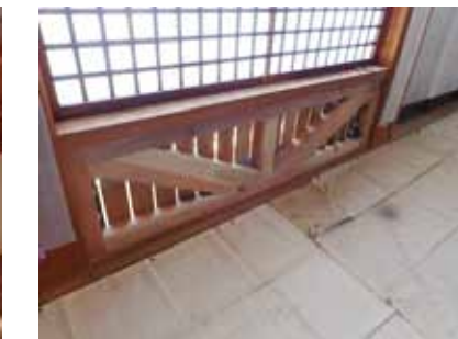
腰下フレーム設置状況
