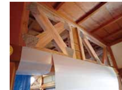
欄間フレーム設置状況
