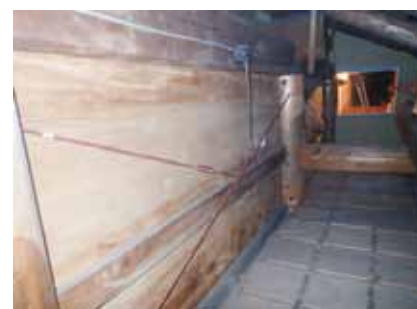
小屋裏鉄筋補強
