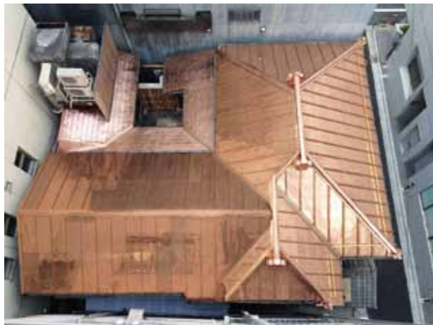
喜代川屋根銅板葺き替え
