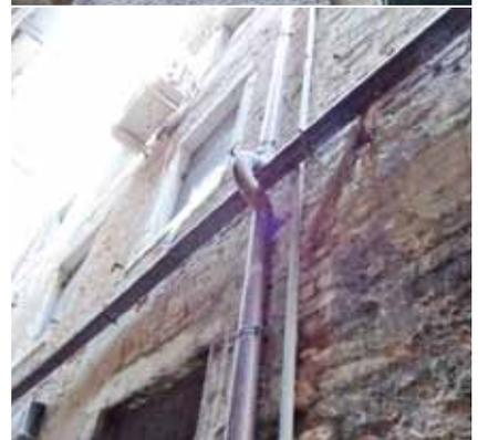
ベニス路地 写真上：レンガ組積漆喰 開口部木枠と石枠が混在 配管露出 写真下：レンガ組積開口部は木枠 芸術的な曲がりが見間違えそう
