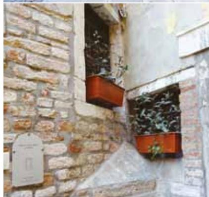
ベニス路地 写真上：左壁レンガ組積と右壁レンガ組積石組積が混在 写真下：壁入隅に開口部とプランター 通行する人に優しい気配り
