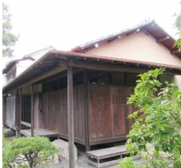
氷室庭園椿庭園の住宅
