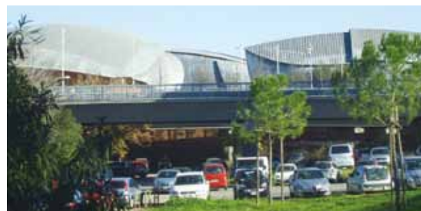
Auditorium Parco della Musica Corso Di Franciaを挟んで「三匹のスカラベ」を捕捉
