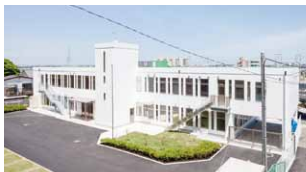
外観南西面完成写真
