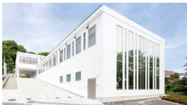
外観南東面完成写真
