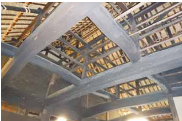
高室家 - 土間の小屋組
