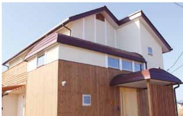
壁の仕上は板張りとしリシン吹付 屋根はガルバリウム鋼板
