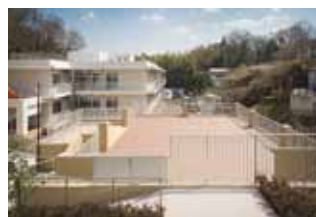
旧恵和館を減築した大きな広場
