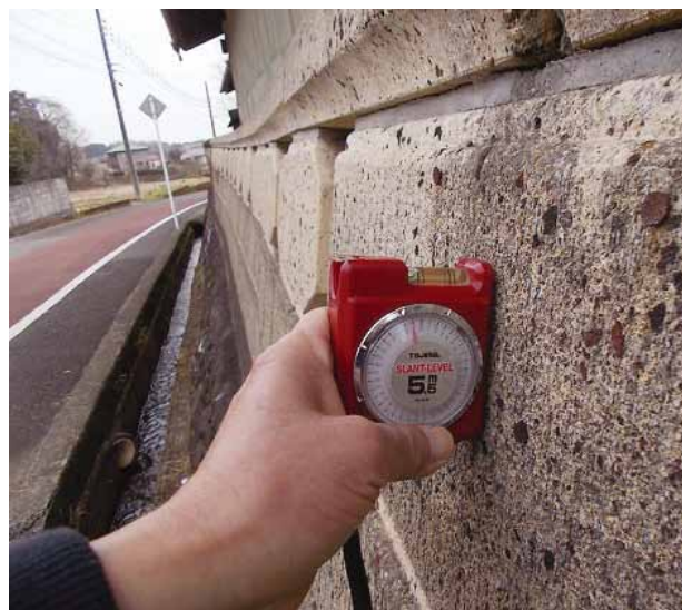
ブロック塀の勾配調査（ブロック塀調査）
