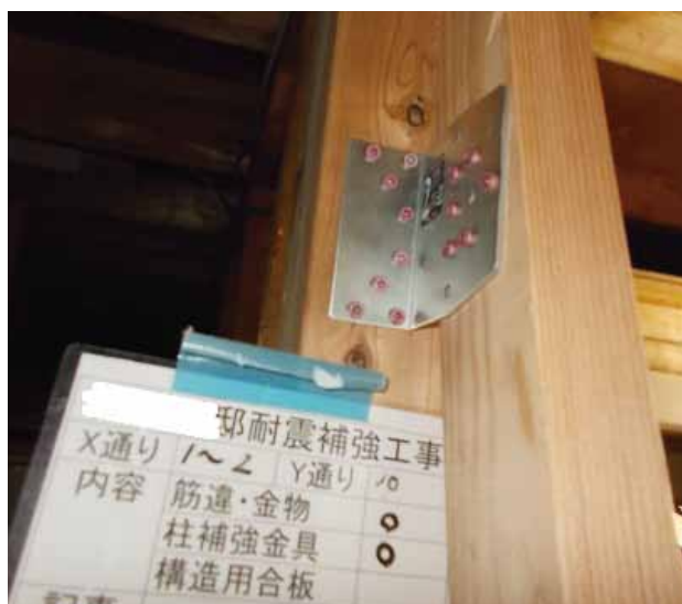
筋違と金物の取付（耐震改修）
