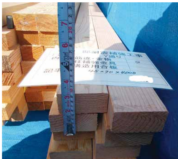
筋違の厚み確認（耐震改修）
