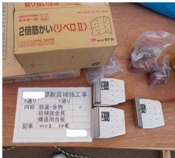
筋違金物確認（耐震改修）
