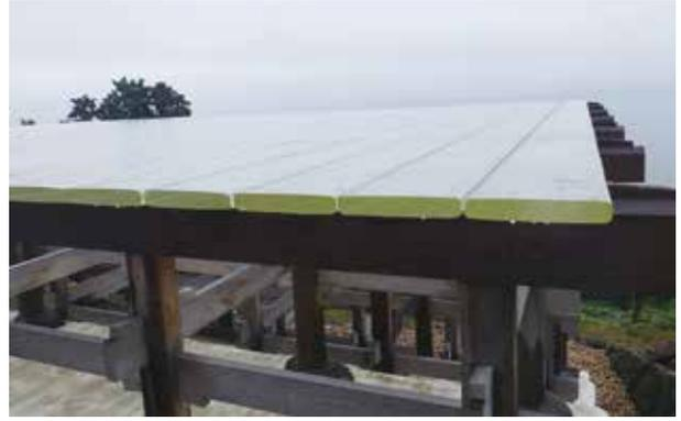
「光学硝子舞台」檜の懸造りと光学硝子
