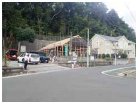
上棟時の状況（2021年10月）
