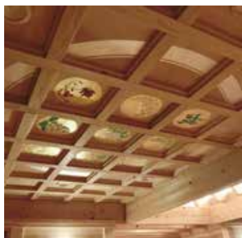
天井の格子は意匠の為だけでなく、水平剛性を確保する為の構造体となっています。
