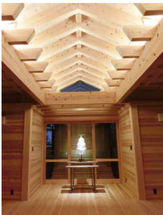
天井の格子は意匠の為だけでなく、水平剛性を確保する為の構造体となっています。
