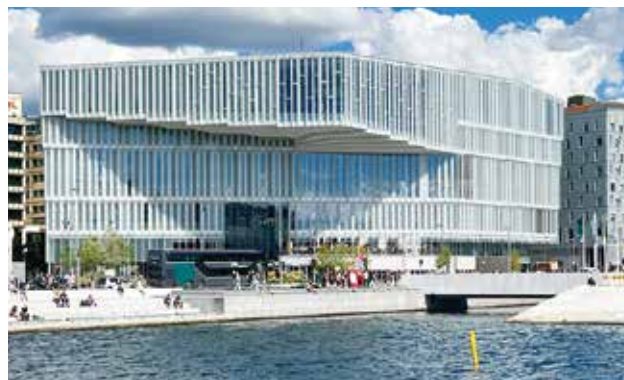
再開発地区の海辺に建つ。右にはオペラハウスが隣接
