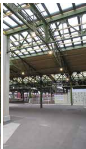
平屋部分鉄骨架構
