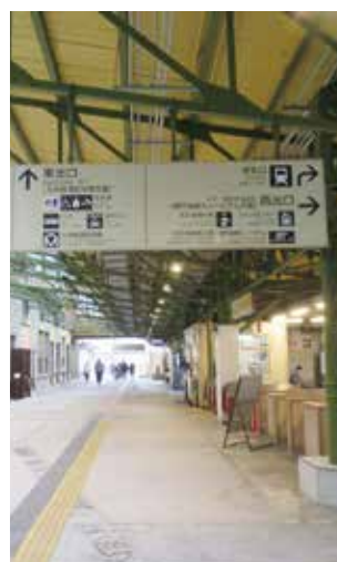
駅舎とホームの間の鉄骨架構
